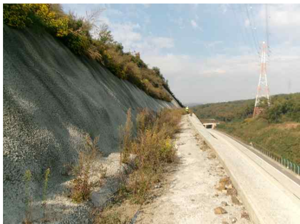
1소단 배수로 전경
